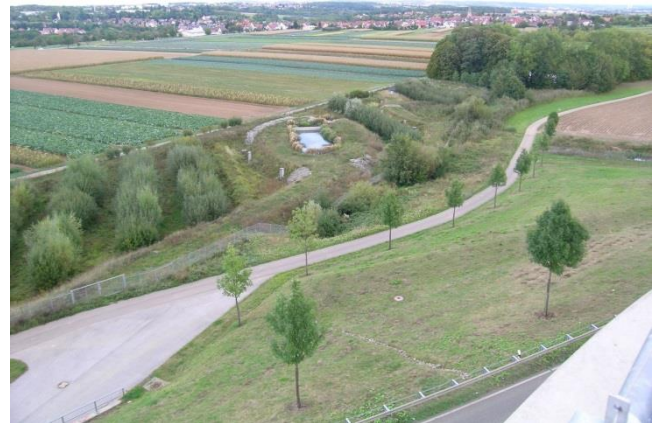
Regenrückhaltebecken Messe, Bereich Flughafenkurve
