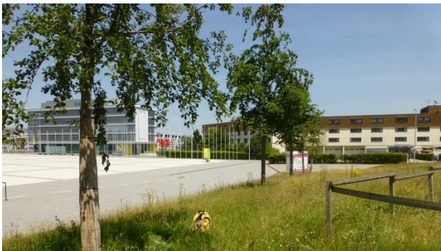
Messe im Bereich der zukünftigen Station NBS
