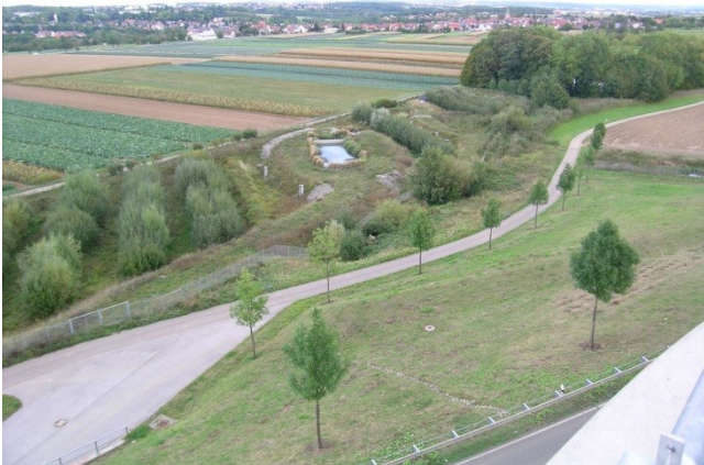
Regenrückhaltebecken Messe, Bereich Flughafenkurve
