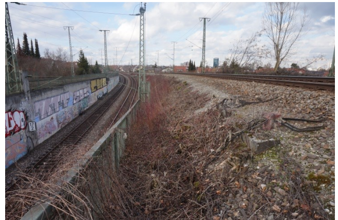
Gleisbereich in Vaihingen
