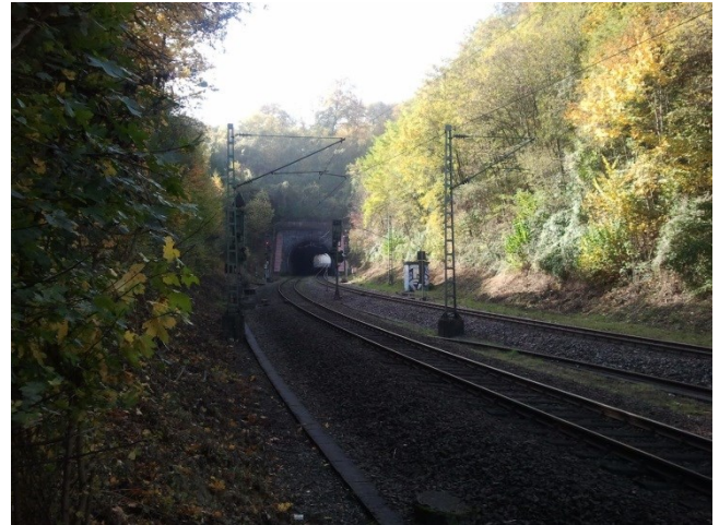
Bestehender Tunnel an der Rohrer Kurve
