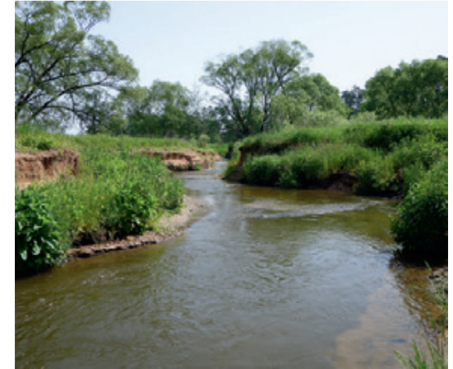
Gewässerrenaturierung mit Bett-Aufweitungen nach Abschluss der Bauarbeiten im Juni 2012 (links) und im Mai 2014 (rechts)
